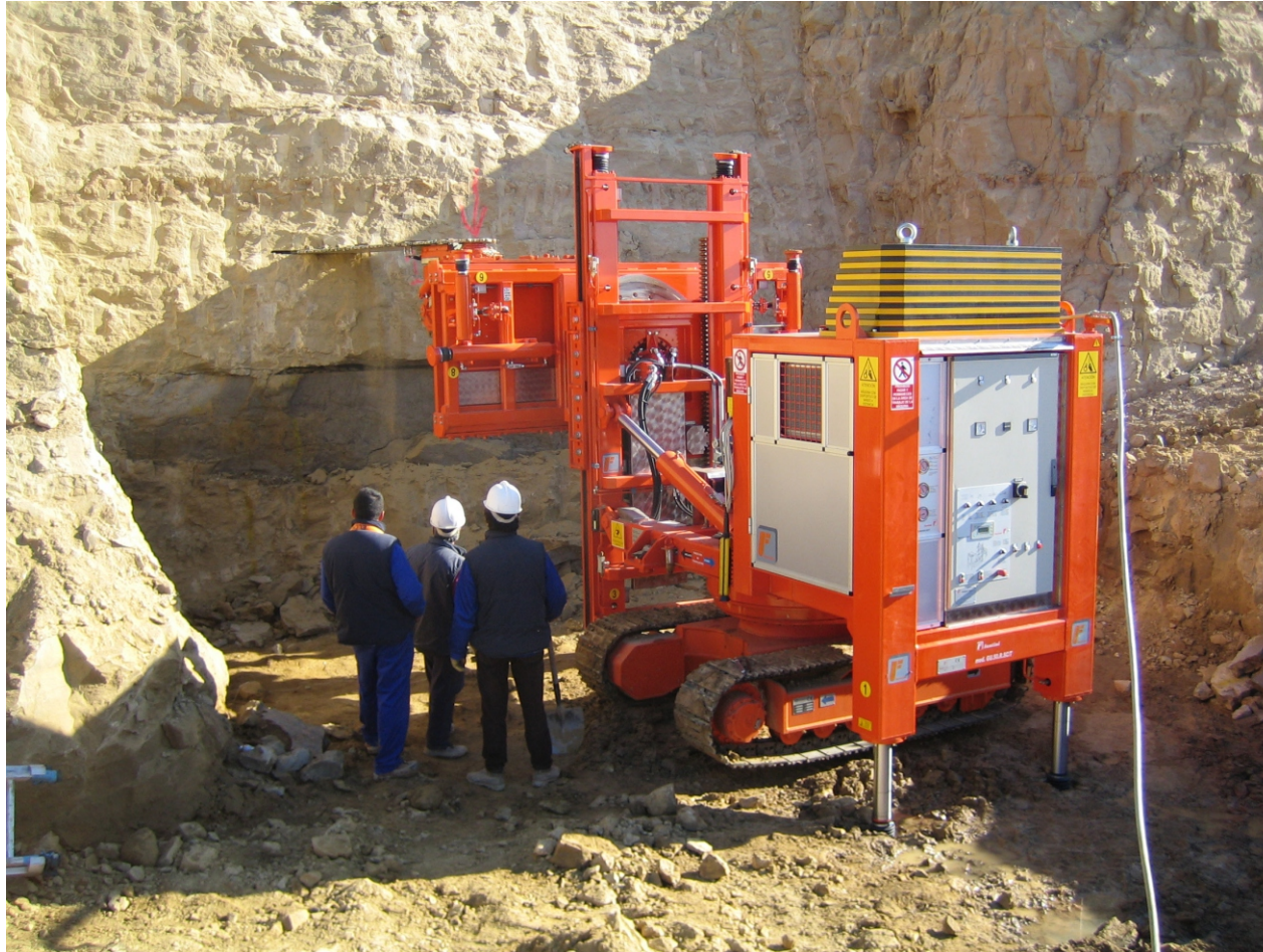
TAGLI ORIZZONTALI AL TETTO HORIZONTAL CUTS AT ROOF LEVEL
