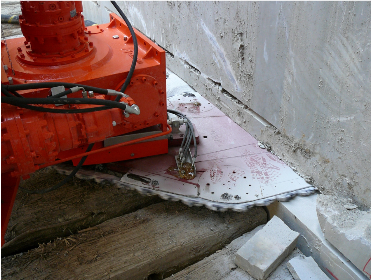
TAGLI ORIZZONTALI A PAVIMENTO CUTTING AT FLOOR LEVEL
